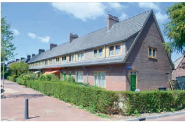
Strakke daklijnen langs de Valkeniersweg met blauw gesmoorde pannen, in authentieke kleuren geschilderde rabatdelen en zinken mastgoten.
