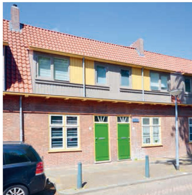
Rijwoningen aan de Voorde met oranje pannendaken, fraai schilderwerk, gekleurde aluminium bakgoten op klossen en fris groene voordeuren.
